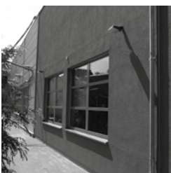
Abb. 5.: Anbau Schmiedepresse außen
