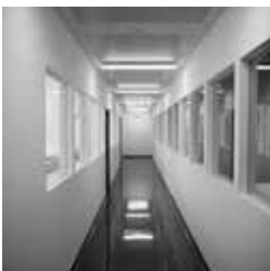
Abb. 3.: Flurbereich mit Brandschutzverglasung
