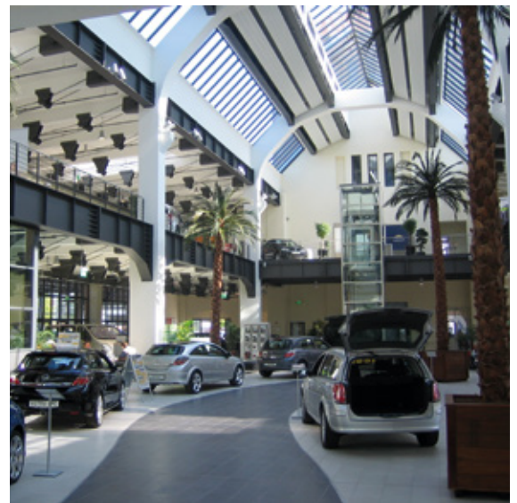
Abb. 1.: Verkaufshalle nach der Sanierung
