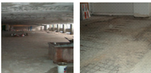
Parkdeck während der Sanierung
