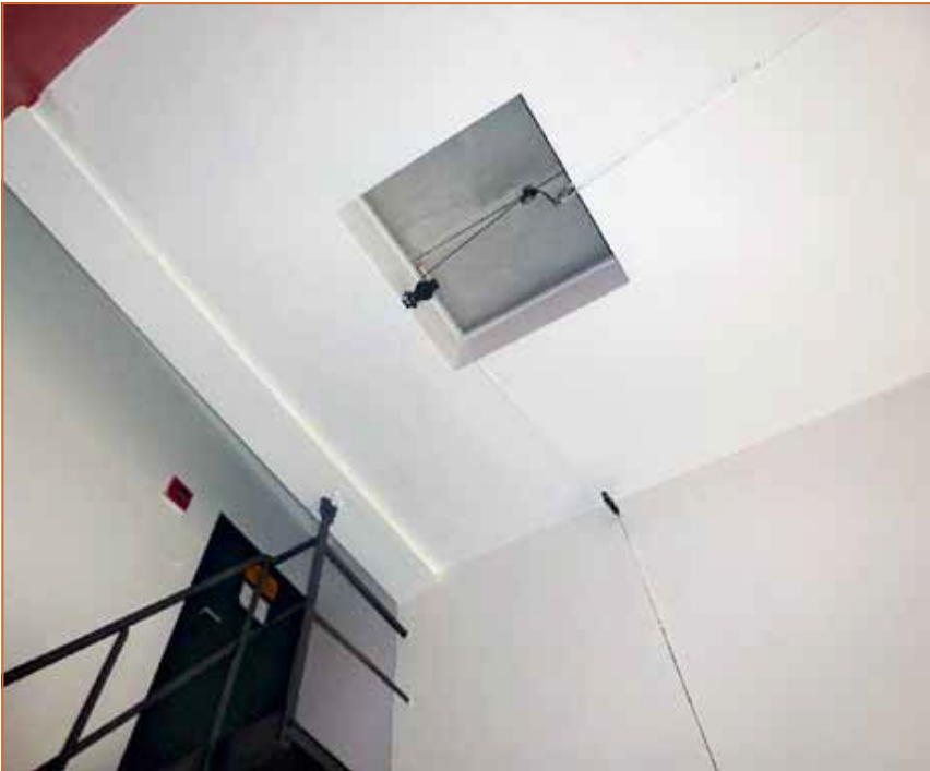
Abb. 2: Eine zeitgenössische Rauchklappe über Seilzug und Hebel manuell im obersten und Erdgeschoss öffnen- und schließbar.
