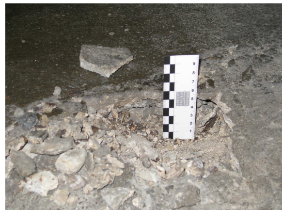
Abbildung 2: Ausbruchstellen im Fahrbahnbeton der untersuchten Tiefgarage
