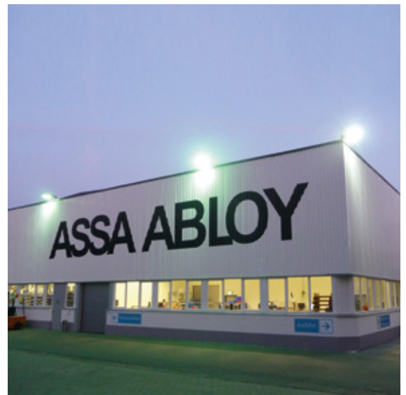
Erarbeitung eines ganzheitlichen Brandschutznachweises für die Leuchtenhalle der ASSA ABLOY Sicherheitstechnik GmbH
